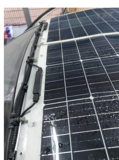
ภาพแสดง หัวฉีดสเปรน้ำ บนแผงโซลาร์เซลล์
