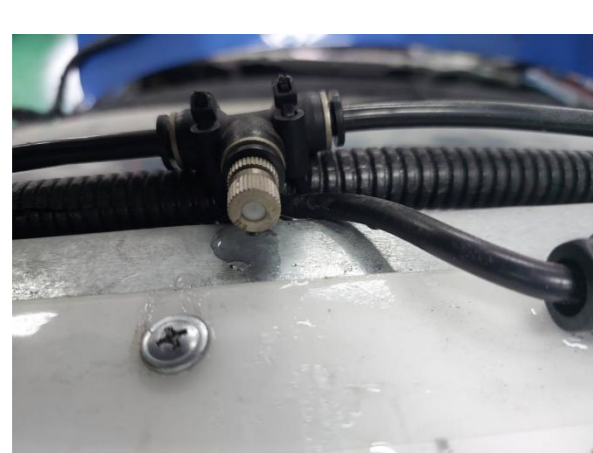
ภาพแสดง หัวฉีดสเปรน้ำ บนแผงโซลาร์เซลล์
